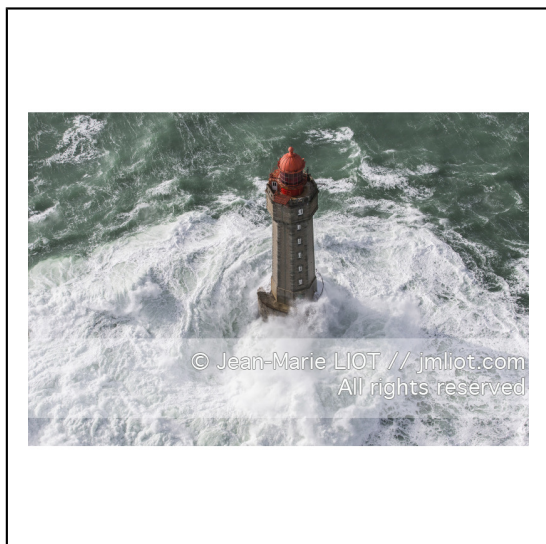
France, Finistère (29), Ile d'Ouessant, 8 Février 2014, Les phares de Bretagne dans la tempête Ruth, Phare de la Jument pointe de Pern (Vue aérienne).Photo : Jean-Marie Liot / Hemis.//.France, Finistere (29), Ile d'Ouessant, February 8th 2014, Britain lighthouse in stormy weather during storm Ruth, Jument Lighthouse, Pern headland (aerial view).Photo : Jean-Marie Liot / Hemis
