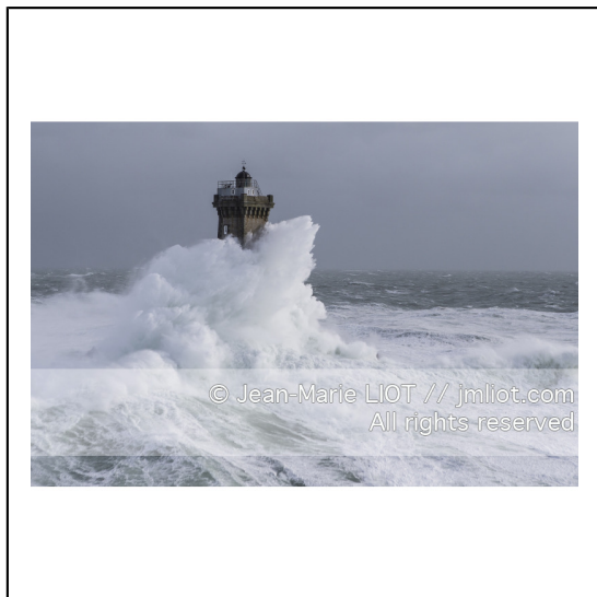
France, Finistère (29), Mer d'Iroise, 8 Février 2014, Les phares de Bretagne dans la tempête Ruth, Phare de la Vieille (Vue aérienne).Photo : Jean-Marie Liot / Hemis.//France, Finistere (29), Iroise Sea, February 8th 2014, Britain lighthouse in stormy weather during storm Ruth, Phare de la Vieille (aerial view).Photo : Jean-Marie Liot / Hemis
